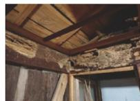
シロアリ被害で穴の開いた梁を、ガスバーナーで焼いた杉板で覆い、隙間は乾燥した竹で取めました。
