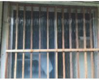
雨戸がなかった窓。台風時の飛来物防御のため、透明の波板スレートと角材で打ち付けました。
