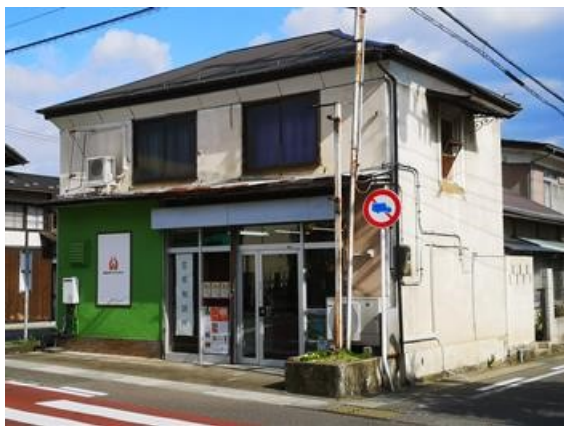
【写真5 空き家相談所 外観】
