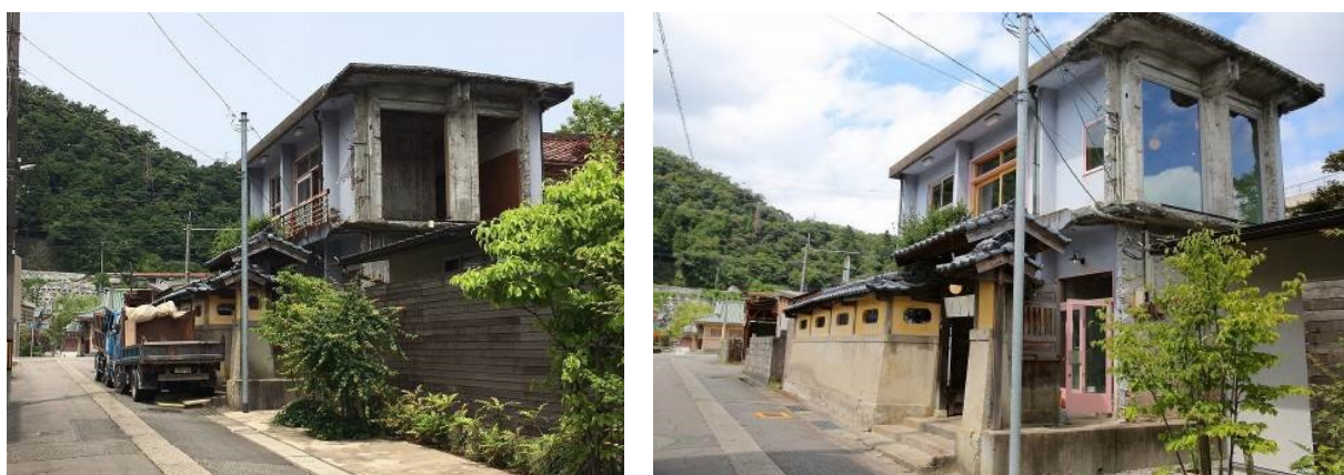
図 14 改修前(左)と改修後(右)の LOBBY
