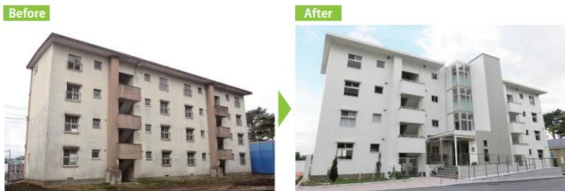
図7 UR賃貸住棟へのエレベータ設置
