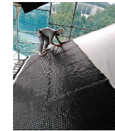
防水通気シート施工 (1工程)
