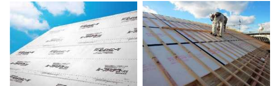
既存工法 = 透湿シート + 胴縁 (2工程)
