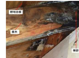
※結露による腐食(合板・シート裏)
