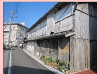
空き家の除却
