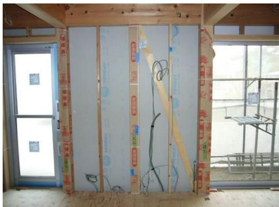
図 15 断熱補強工事の例（断熱材設置）
