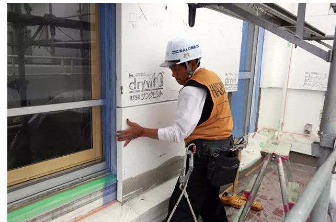
断熱材（厚さ50mm）を外壁に貼り付け
