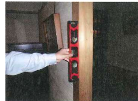
水平器による 柱の傾きの計測
