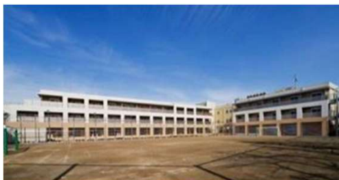
学校を改修して整備した事例
