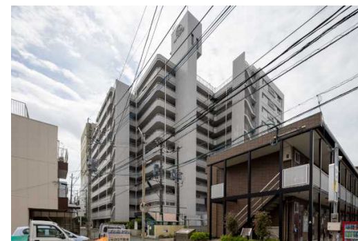
再建マンションの外観
