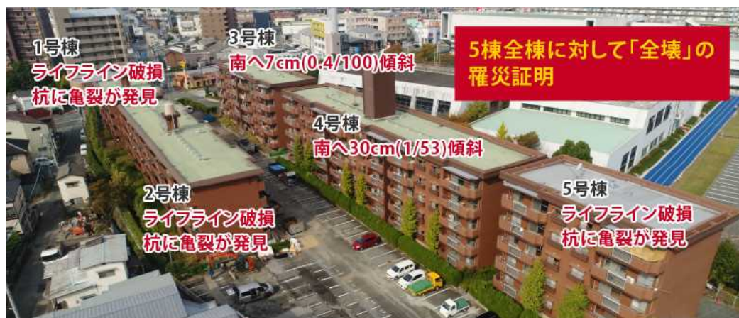
被災状況①
