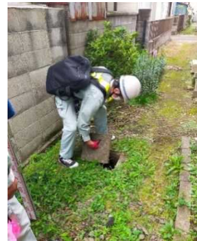
写真2 共用通路調査状況
