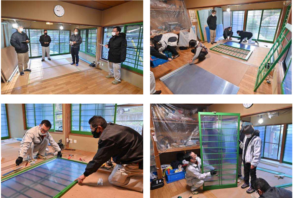
図 2-14 D10 改修プログラム（1 回目）の作業写真
