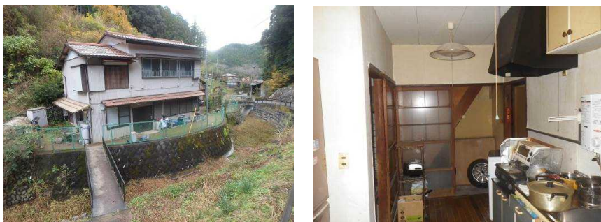
図 2-6 対象住宅の概要（木造 2 階建て、1951 年築、延床面積 110.99 m 2 ）
