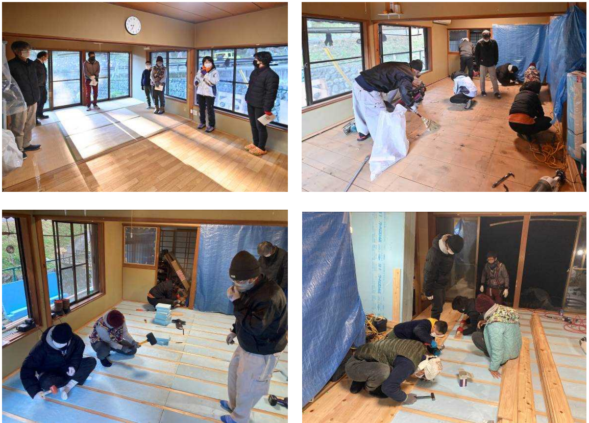
図 2-15 D10 改修プログラム（2 回目）の作業写真
