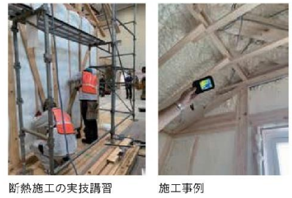
断熱施工の実技講習 施工事例
