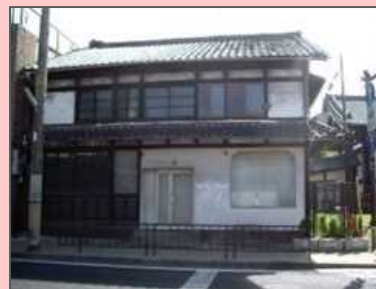
空き家の活用
