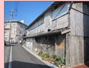
空き家の除却
