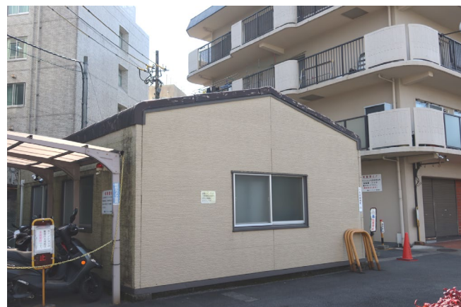
新設された集会所
