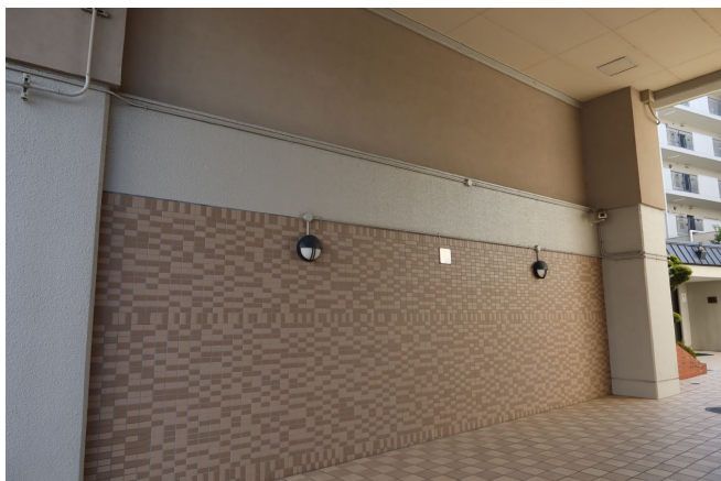
耐震補強されたピロティ壁
