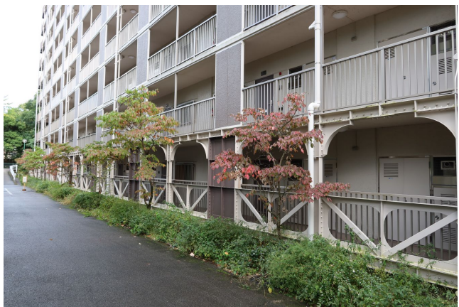
耐震補強された1階共用廊下
