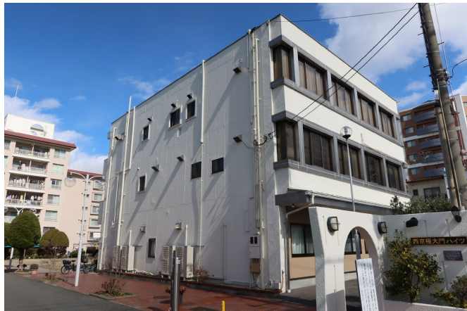
買取し改装したコミュニティホール
