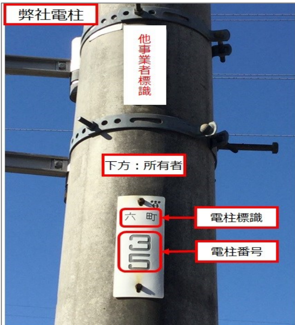
【弊社電柱標識・番号】(表示例：電柱標識「六町」、電柱番号「35」) 電力会社のマークが表示されている標識をご確認ください。 標識が上下に取付されている場合は、下方に取付されている標識が電柱の所有者となります。 ※電柱標識に漢数字が付される場合や電柱番号が、3～4桁表記となる場合があります。
