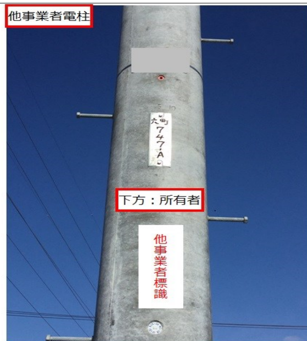
【他事業者標識】 標識が上下に取付されている場合は、下方に取付されている標識が電柱の所有者となります。 他事業者の電柱の移設・改修の場合は、他事業者へお問い合わせください。
