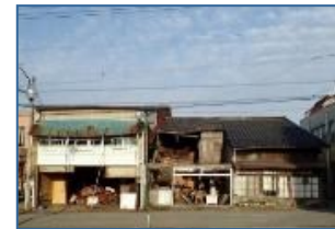
空き家の除却
