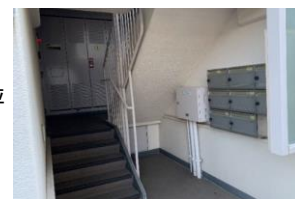
【4階までの階段】 (全6箇所)
