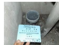
立管:塩ビ形状記憶樹脂内貼り
