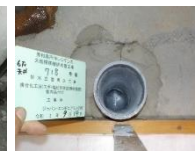
横枝管:エポキシ含浸芯材内貼り
