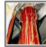
排水立管（鉄管）の破損状況
