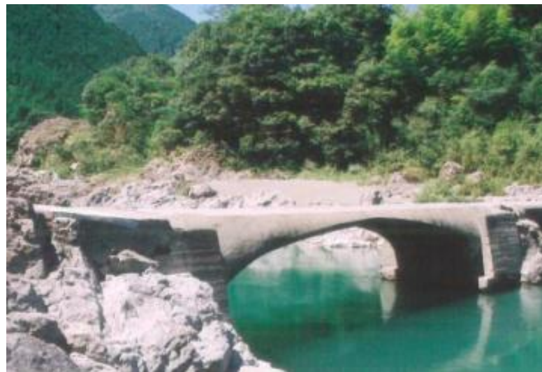
昭和初期の沈下橋（高知県）
