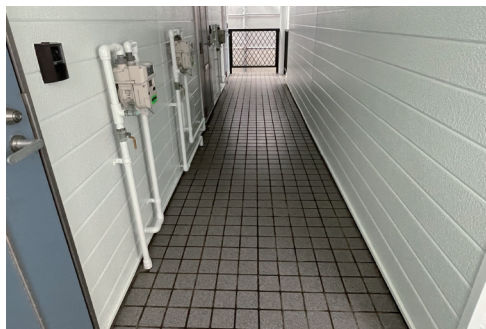
外壁塗替、シーリング打ち直し
