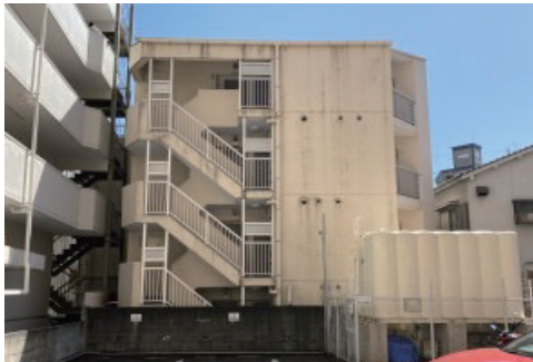
工事実施前外観
