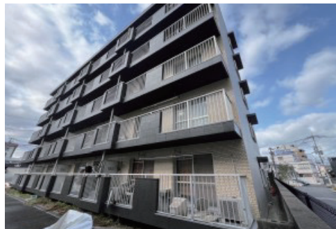
工事実施後外観 (バルコニーの壁面を新たに塗装)
