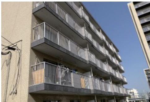
工事実施前外観
