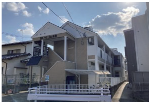
工事実施前外観
