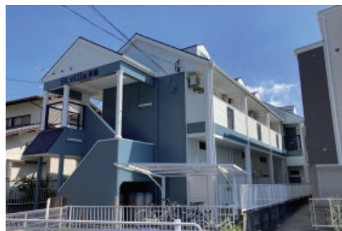
工事実施後外観 (従前と異なる色に塗替)
