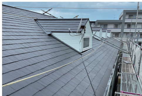
漏水箇所の修復と屋根塗替
