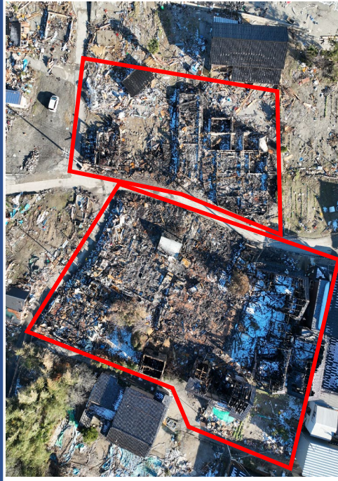
図6 <No. 17> 火災による延焼範囲
