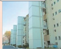
エレベータ設置
