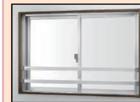
転落防止の手すりの設置
