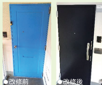
●改修前 ●改修後
