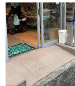
スロープの設置
