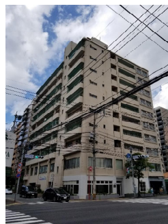
現況建物の外観写真
