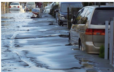
液状化で砂がふき出した例
