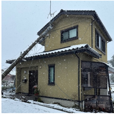
写真 5-1 ガイドライン工法による住宅 (J 形瓦)
