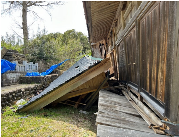
写真 4-1-1 下屋の被害事例
