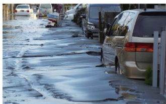
液状化で砂がふき出した例
