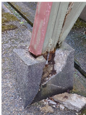
写真 7-4 バットレス脚部の基礎被害
