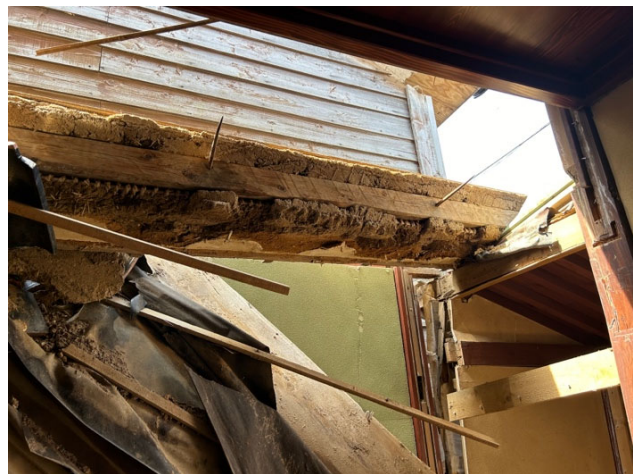
写真 4-1-2 下屋と主屋の境界部での被害事例
