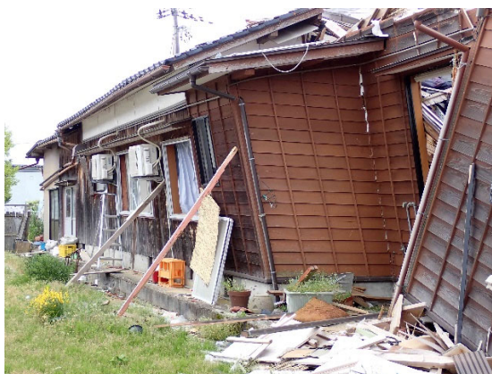
写真 2-1 変形追従性能の高い下見板張り
