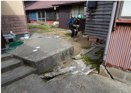
写真 1-1 敷地内への立入許可を得て基礎立上り部分の調査
