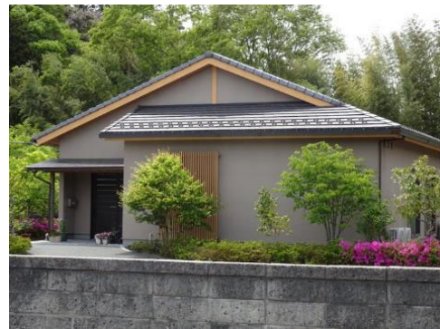
写真 5-4 令和 5 年 5 月の地震後の状況 3)
