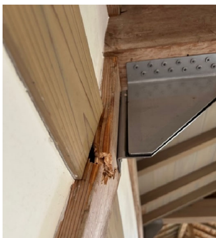
写真 3-1 仕口補強金物による柱の折損と横架材の亀裂
