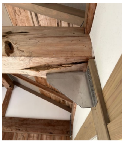
写真 3-1 仕口補強金物による柱の折損と横架材の亀裂
