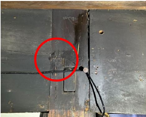
写真 2-3-1 垂壁付き独立柱の折損
