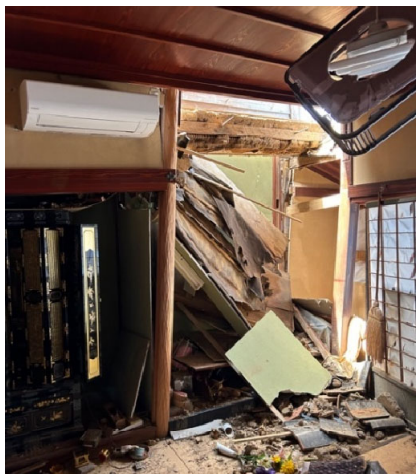
写真 4-1-2 下屋と主屋の境界部での被害事例
