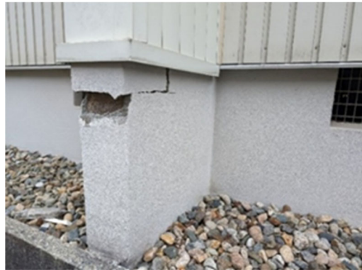
写真 7-3 妻壁の被害、アンカーボルトの被害
