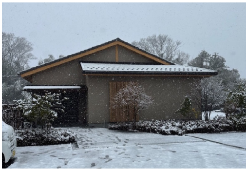
写真 5-3 ガイドライン工法による住宅 (F 形瓦)
