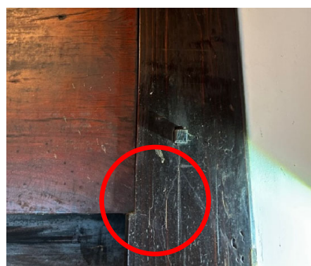
写真 2-3-1 垂壁付き独立柱の折損
