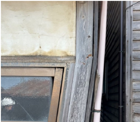
写真 2-3-1 垂壁付き独立柱の折損
