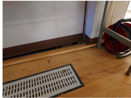
写真 7-1 地盤変状に伴う基礎の移動による上部構造の被害
