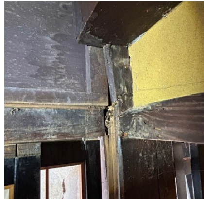
写真 2-3-1 垂壁付き独立柱の折損
