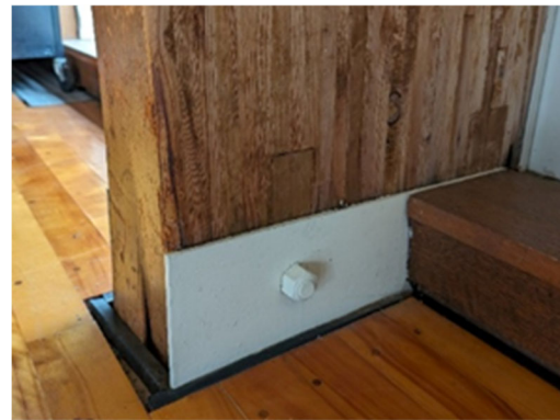
写真 7-2 集成材建築柱脚部の被害
