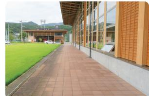
写真3.1 軒による保護と定期的な木材保護塗料の再塗装により、構造材・外壁材の機能と美観を維持している事例(築9年)
