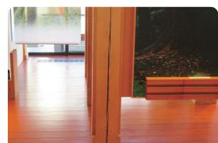
写真3.2 柱に用いた製材に生じた表面割れの事例(築12年)
