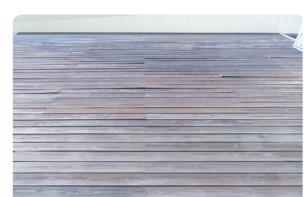
写真3.3 外壁に用いた板材に変形(反り)や木材保護塗料の退色が生じた事例(築16年)
