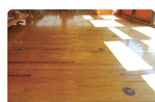
写真3.4 每年ワックス塗布を実施する圧縮木材を利用したフローリングの事例(築17年)
