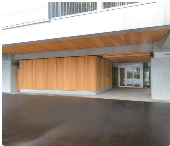
写真3.14 バルコニーによる木質化した外壁面の保護と、雨水が作用しにくい軒裏の木質化を図った事例
