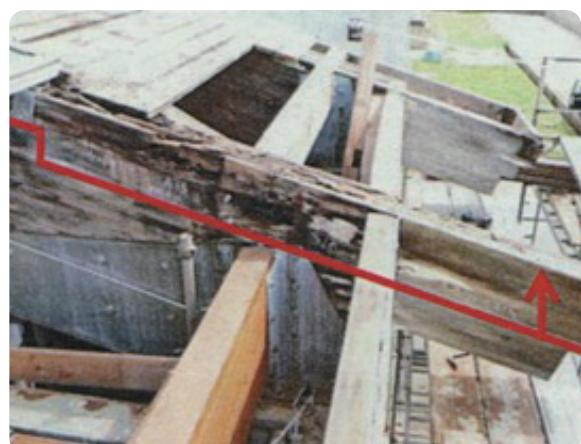
写真3 屋根ガラス面からの結露水で腐朽した小屋梁
