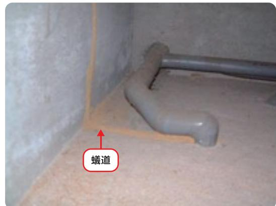
写真1 べた基礎の排水管回りの隙間から構築された蟻道
