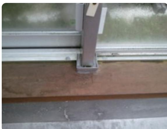
写真2 温水プールサッシ方立の結露受け金物
