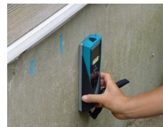
基礎配筋の調査
