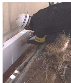
外壁の断熱化工事
