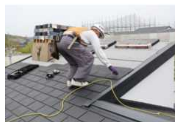
屋根の断熱化工事
