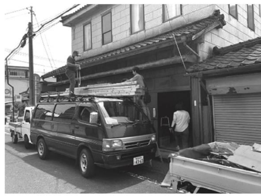
図3 横川 Kito 改修前の古民家
