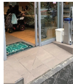
スロープの設置
