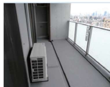
室外機を置いても安全な幅の広いバルコニー
