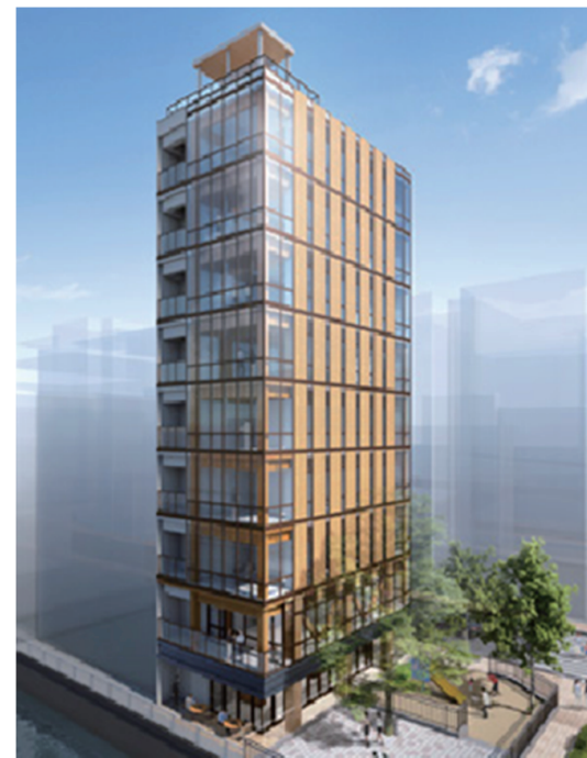
地上9階建て混構造事務所
