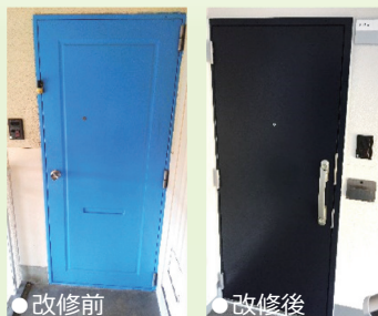
玄関扉の断熱改修
