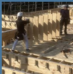
● 2F-79～2F-82 根太の切断作業が生じた
