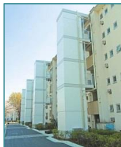
中層住棟へのエレベーター設置
