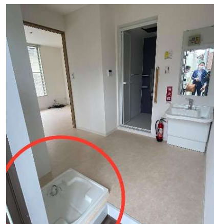
女性入居者必須の洗濯 機置き場も設置
