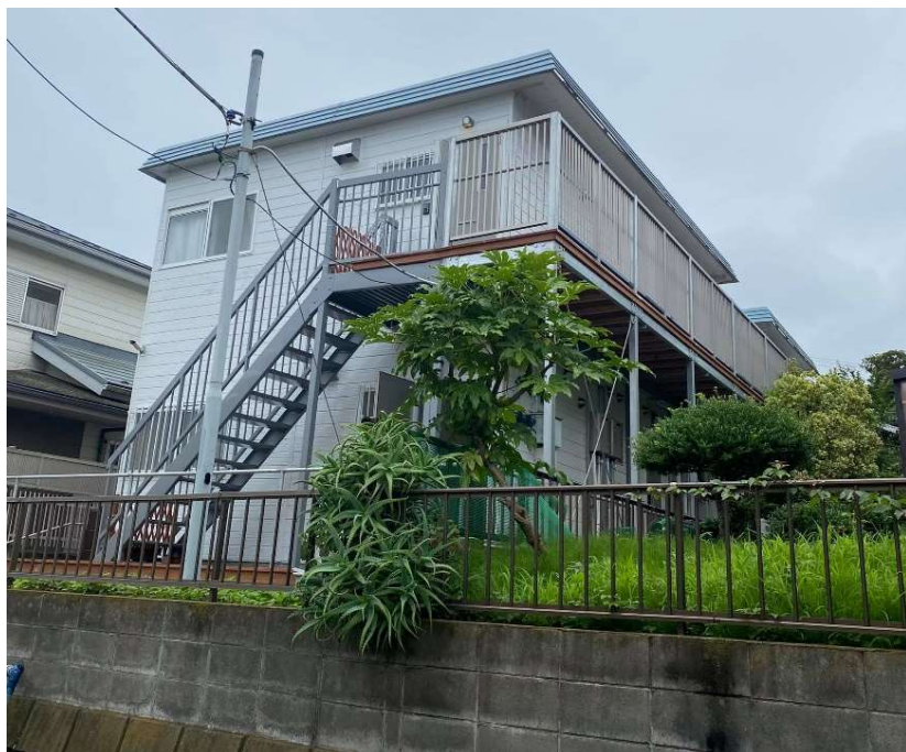
2階建て2棟のアパートをフルリノベ。 外回りにデッキを設置
