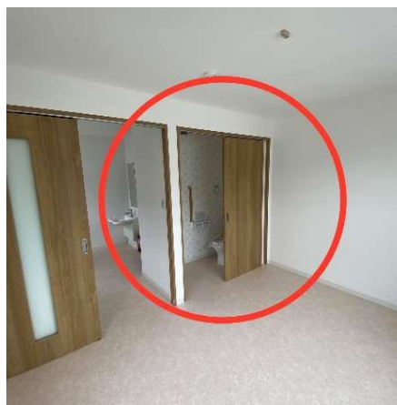
もともとの押し入れを トイレに改修
