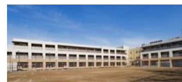
学校を改修して整備した住宅
