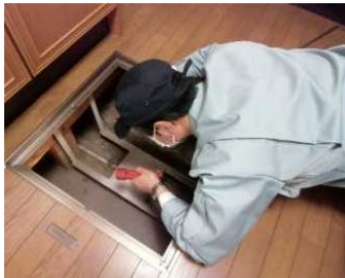
「土台・床組、基礎」調査の様子
