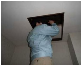
「小屋組・梁」調査の様子
