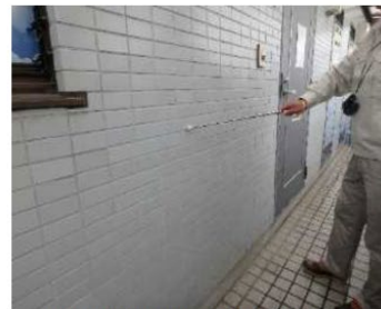
「外部（外壁）」調査の様子
