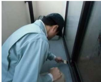
「外部（バルコニー）」調査の様子
