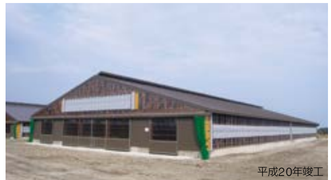
オホーツクはまなす育成牧場牛舎(北海道) 詳細参照P27 延べ面積1,774.46m 2 だが、畜舎には緩和措置があるため、防火壁(法26条1項3号)と小屋裏隔壁(令114条3項3号)を設けていない。
