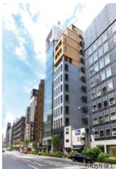
銀座高木ビル(東京都) 上から数えて階数4を木造による耐火構造とした地上12階建ての耐火建築物である。
