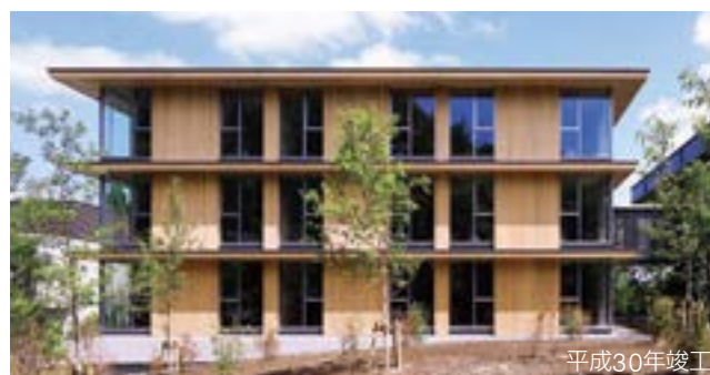
平成30年竣工 竹中研修所匠新館 CLTパネルを壁・床・屋根に現して用いた研修施設
