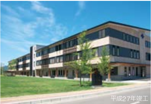
紫波町役場 (岩手県: 軒高14.53m最高高さ14.98m) 計画当時の高さ制限(軒高9m超、最高高さ13m超)により 1時間準耐火建築物とした建築例
