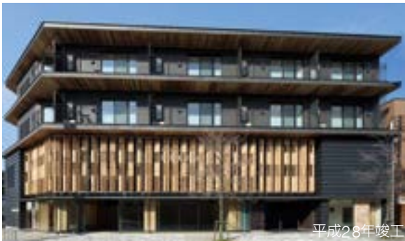
京都木材会館(京都府) 主要構造部に大臣認定を受けた耐火構造部材を用いた木造4階建て耐火建築物である。
