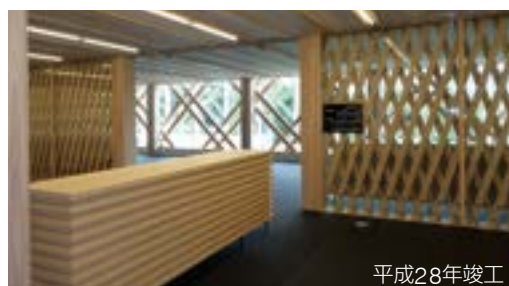
高知県自治会館庁舎(高知県) 天井仕上げ材を準不燃材料とすることで、木製ブレースを現しで使用し、独立柱にスギ材を張った建築例 天井には、見付面積を天井面の面積の1/10以下としたルーバー(スギ)を用いている。
