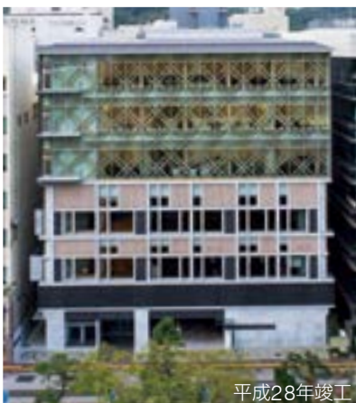
高知県自治会館庁舎（高知県） 防火地域に建つ、1～3階をSRC造、4～6階を木造とした耐火建築物の庁舎である。
