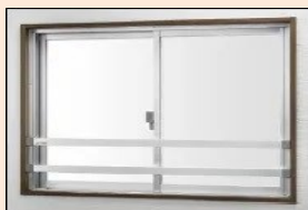
転落防止の手すりの設置
