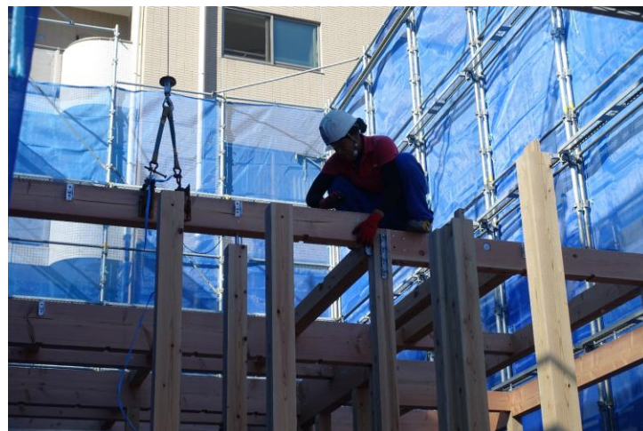
足場とびが建て方
