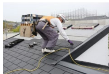
屋根の断熱化工事
