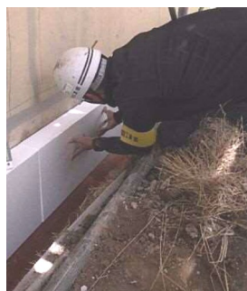
外壁の断熱化工事
