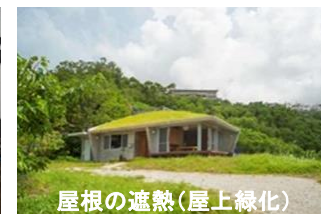
屋根の遮熱(屋上緑化)
