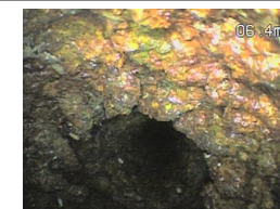
既存セクチャー継手内部
