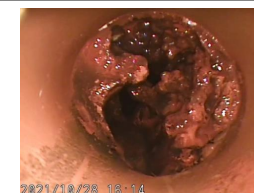
既存給水管内部
