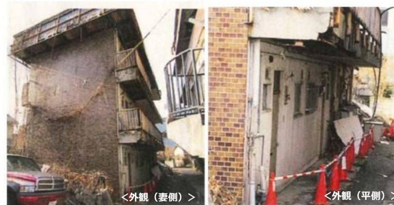
建物の傷みが著しく外壁の剥落、鉄骨の露出などが見られる事例
