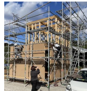
実大施工試験（生産性実測）
