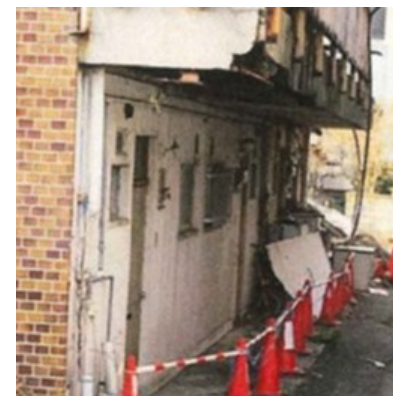
外壁剥落等の危険な状態
