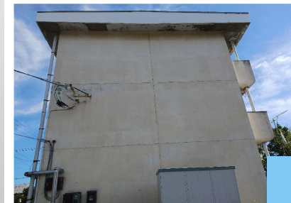
塗装の剥がれがみえます。
