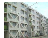
共同住宅 (外付けフレーム補強)
